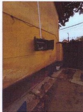
udvari homlokzat és villanyóra
