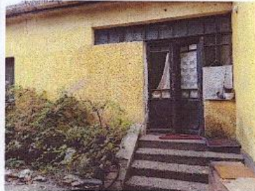
udvari homlokzat (2 sz. lakás bejárata)
