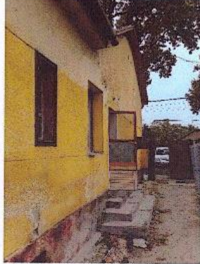
udvari homlokzat (1 sz. lakás bejárata)
